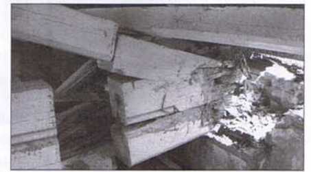
Bedrohlich: Schwammschäden
