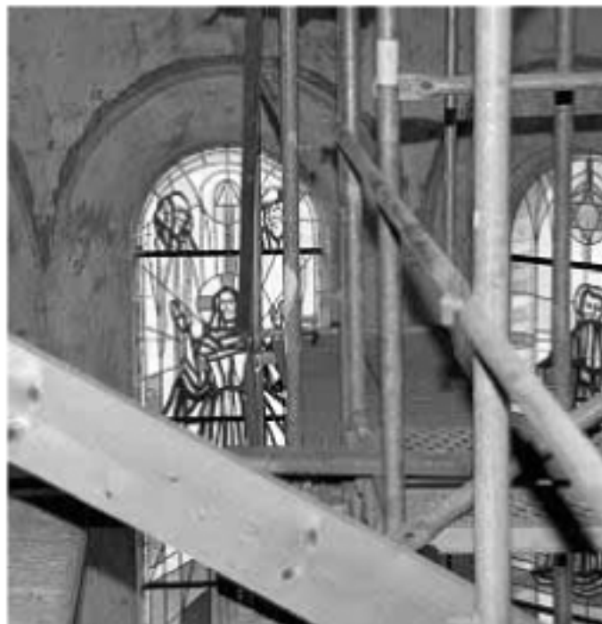
Noch steht das Gerüst in der Vicheler Kirche.
