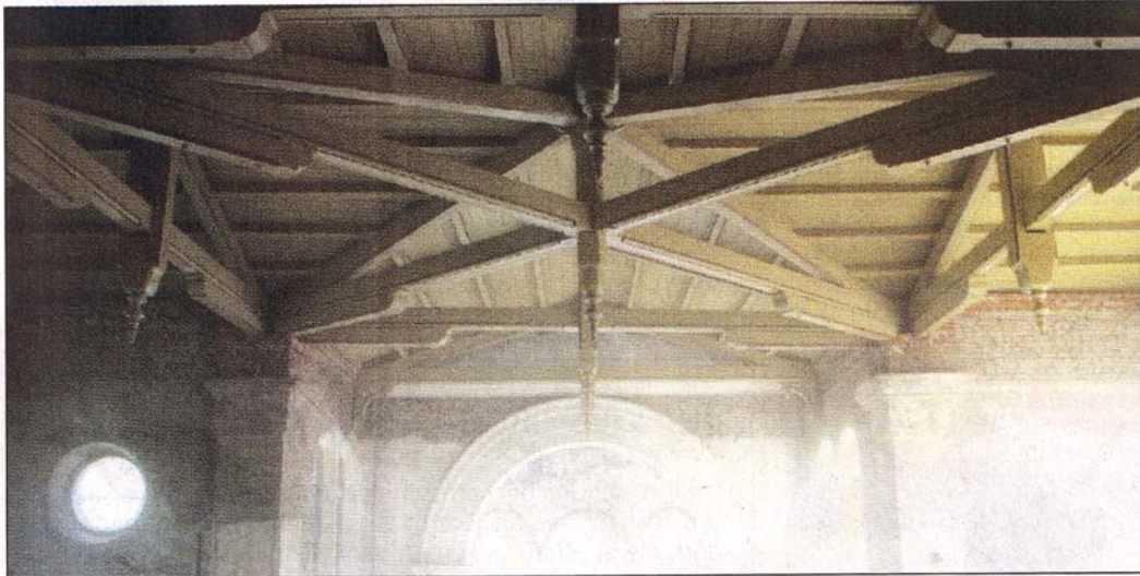
Der Anfang ist gemacht. So sieht die neue Decke der Vicheler Kirche aus, durch die kein Wasser mehr in das Gotteshaus gelangen soll.
